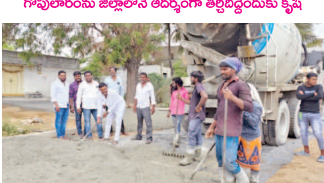
సీసీ రోడ్డు పనులను ప్రారంభిస్తున్న సర్పంచ్
